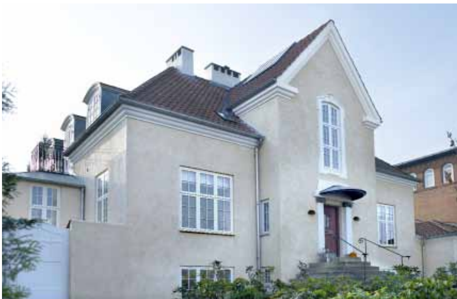
Rødstens villa, udvendig isoleret med ISOPORE isoleringssystem. Efterfølgende tyndpudset med indfarvet St. Astier NHL mørtel.
